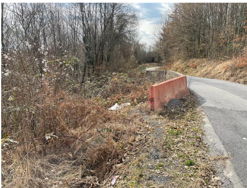
Slika 2. Pogled na dio prometnice zaštićen ogradom tipa New Jersey
